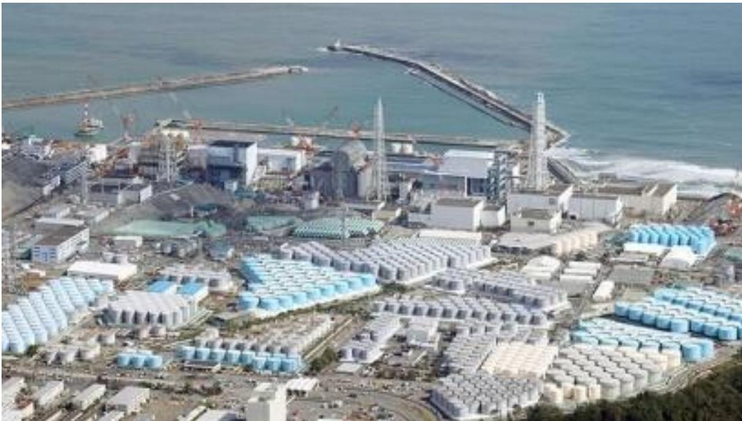
*Figura 24 – Serbatoi contenenti acqua trattata costruiti intorno alla centrale di Fukushima*
